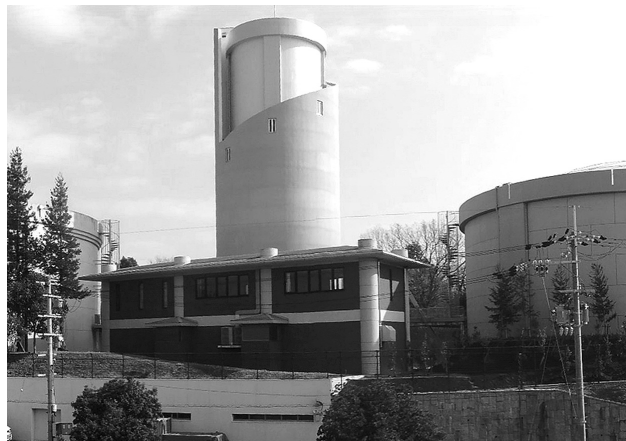
はつが野配水場
